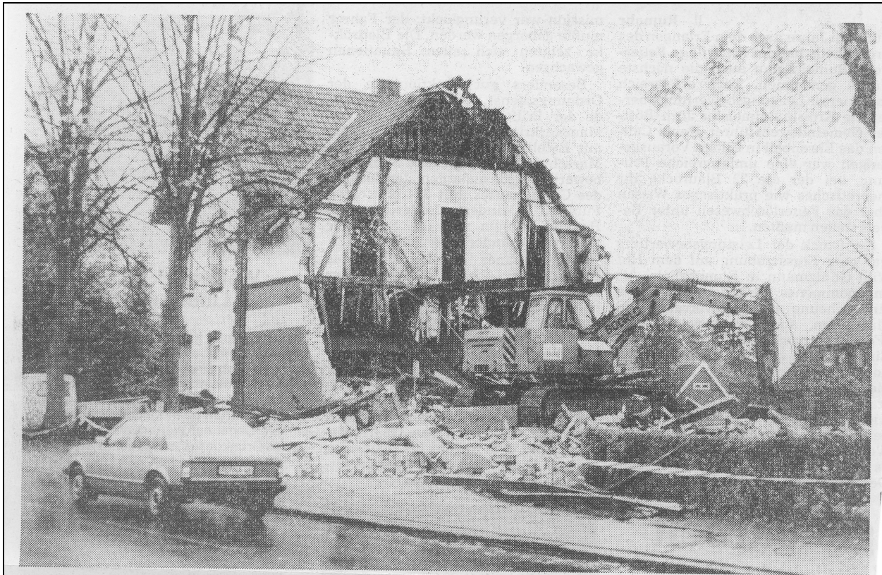
Abgerissen wurde gestern das Hamannsche Haus in Bordesholm.
